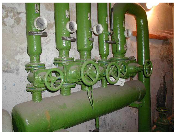
Obr. 2.3.3 – 1,2 Rozdělovač topné vody, Sběrač topné vody
