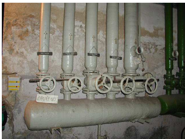
Obr. 2.3.3 – 1,2 Rozdělovač topné vody, Sběrač topné vody
